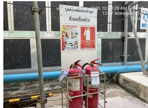
รูปที่ 25 ถังดับเพลิงเคมี พร้อมป้ายแนะนำการใช้งาน
