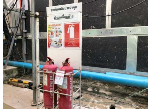
รูปที่ 25 ตู้ดับเพลิงเคมี พร้อมป้ายแนะนำการใช้งาน (ต่อ)
