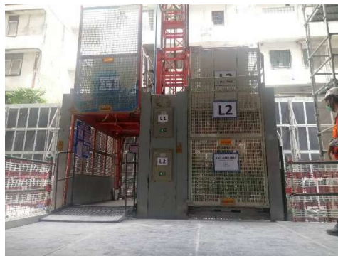
รูปที่ 51 ลิฟต์ที่ใช้ทั้งขนส่งวัสดุและโดยสารชั่วคราว
