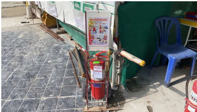
รูปที่ 25 ถังดับเพลิงเคมี พร้อมป้ายแนะนำการใช้งาน
